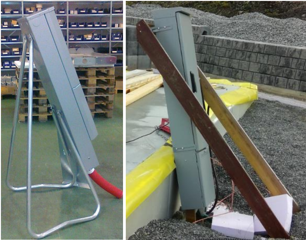
Bilde 2: Bruk av tilknytningsskap som byggestrøm (grøft skal være gjenfylt før spenningssetting).
